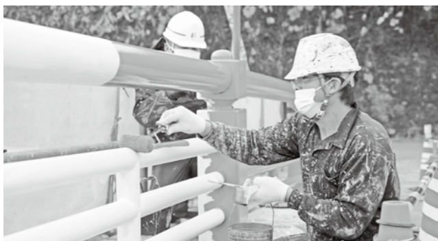
▲見る見るうちにきれいな朱色に塗装されていく弁天橋
