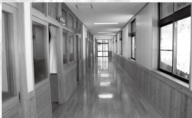
廊下はフローリング敷きで、壁や扉にも木材を多用しています
