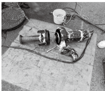
ポンプに物が詰まると、ポンプを引き上げて分解し、修理します
