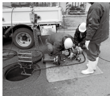
ポンプに物が詰まると、ポンプを引き上げて分解し、修理します
