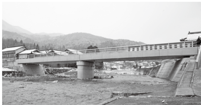
完成した市場橋
