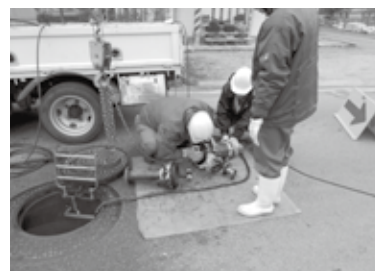
ポンプに物が詰まると、ポンプを引き上げて分解し、修理します
