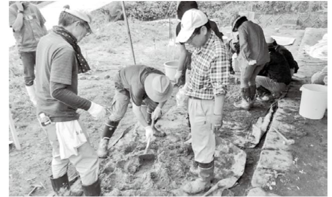
▲壊れた土壁を崩して、新たに練り直す参加者
