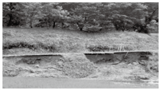
市道吉井北線 被災直後
