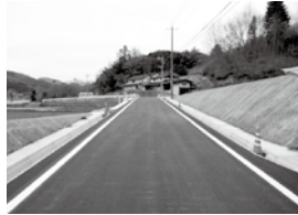
市道東南線工事完成
