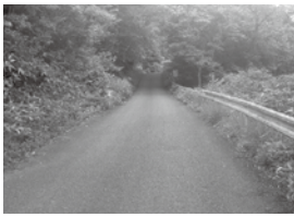
市道高瀬線工事施工前
