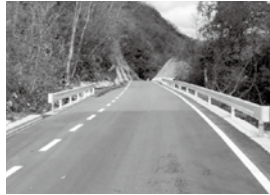
市道高瀬線工事完成
