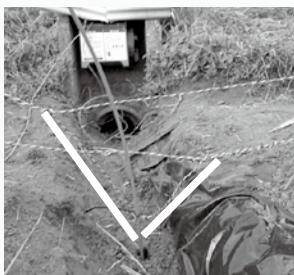
水路には白線部の電線を追加。（本村町野谷のヌートリア対策）
