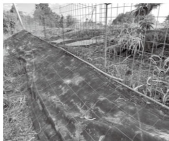
▲直管パイプでの下部補強と、防草シートによる法面保護
