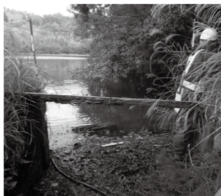
▲洪水吐の点検
