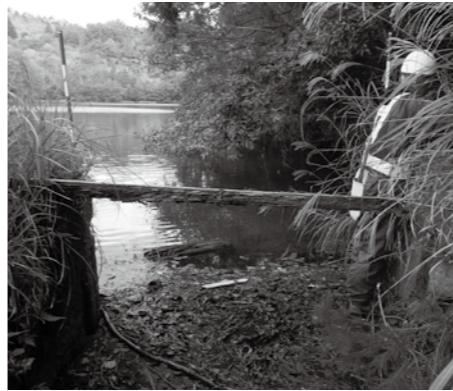
▲洪水吐の点検
