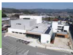
庄原市民会館・庄原自治振興セン ター改修工事完了(令和5年3月)
