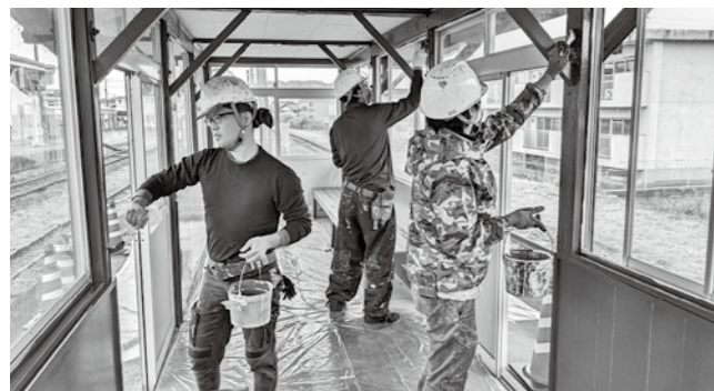
▲ムラなく塗装作業を行う塗装業者の皆さん
