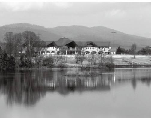
国営備北丘陵公園北入口のエントランスセンター国兼
