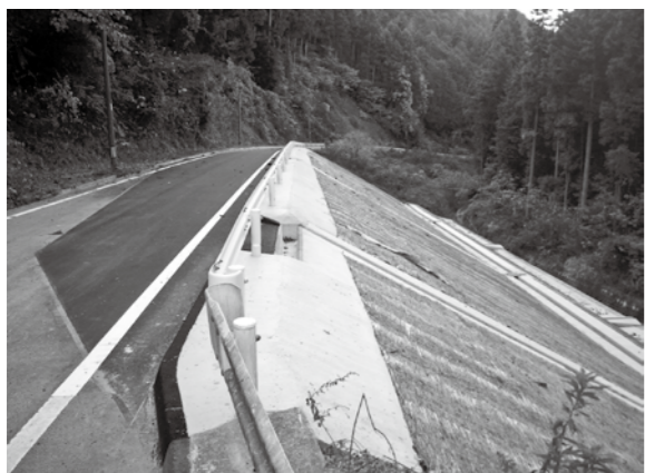
災害復旧事業による復旧後の状況
