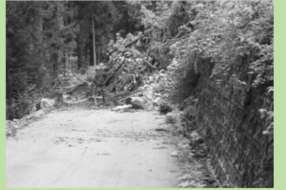
5月に西城町で発生した土砂災害
