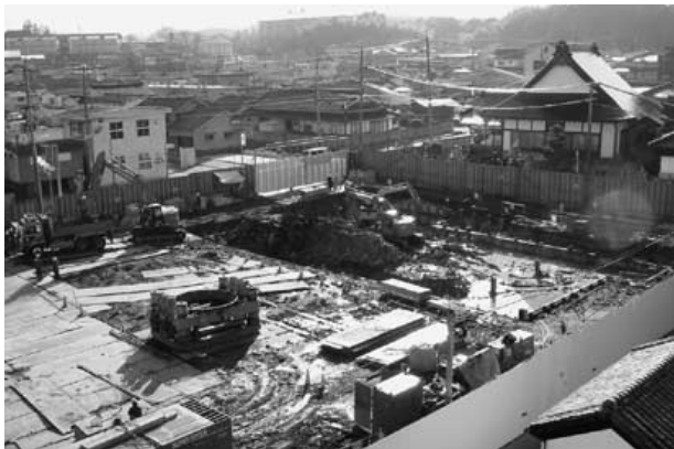
本格工事が始った新庁舎建設
