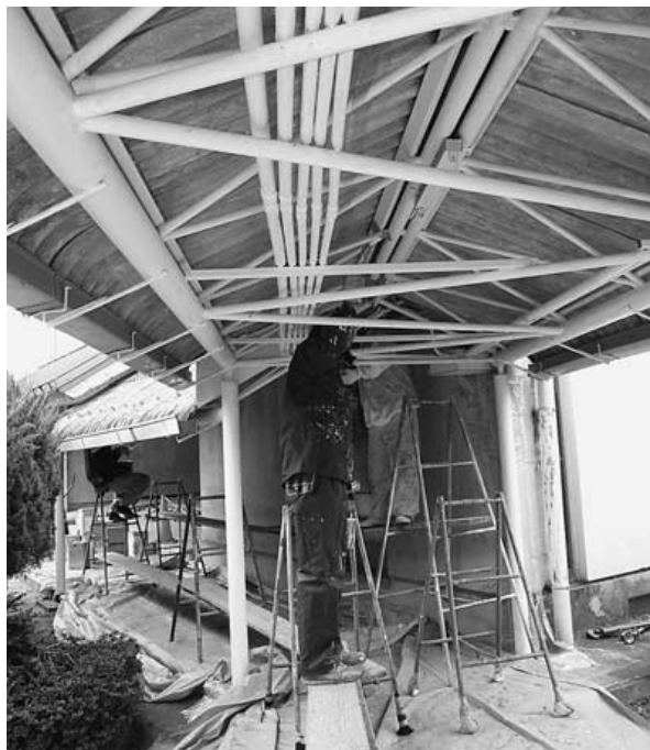
渡り廊下の鉄骨をていねいに塗る会員
