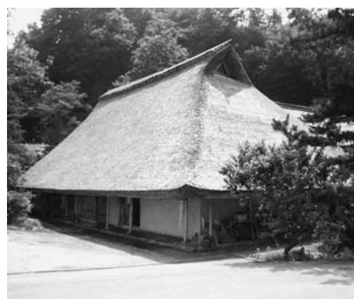
茅葺き屋根が美しい堀江家住宅
