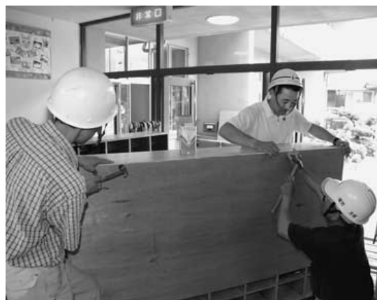
庄原保育所で下駄箱を補修
