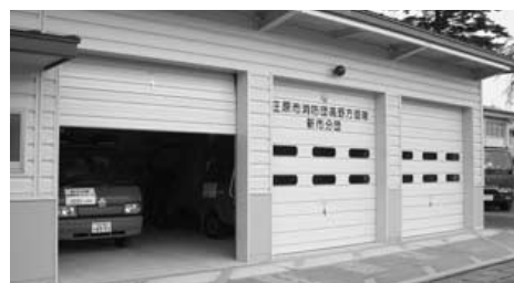
完成した高野地区多目的倉庫
