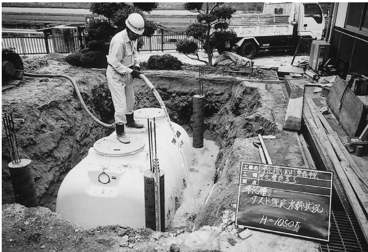
浄化槽設置工事
