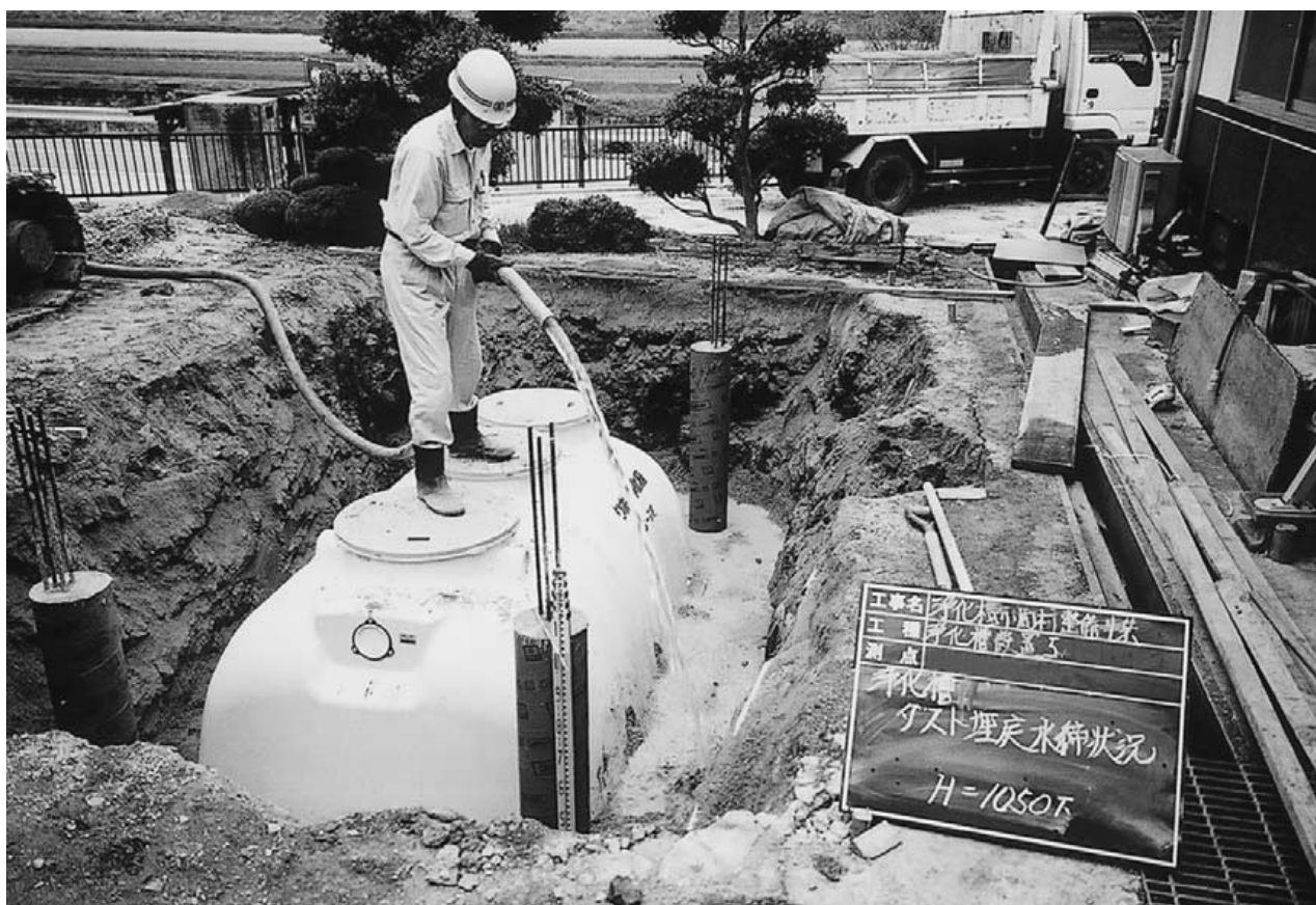
浄化槽設置工事
