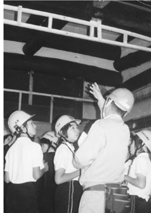
工務店の工事現場を訪問(庄原小)
