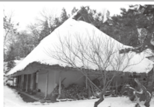
修復準備が進む堀江家住宅
