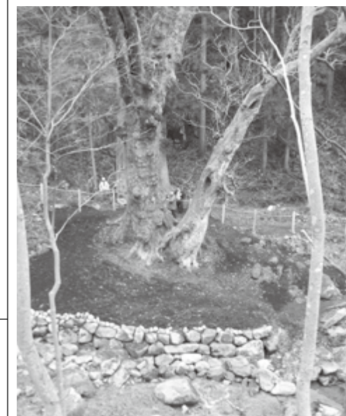
工事を終えた熊野の大トチ
