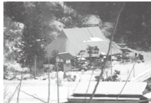
修復を受ける荒木家住宅
