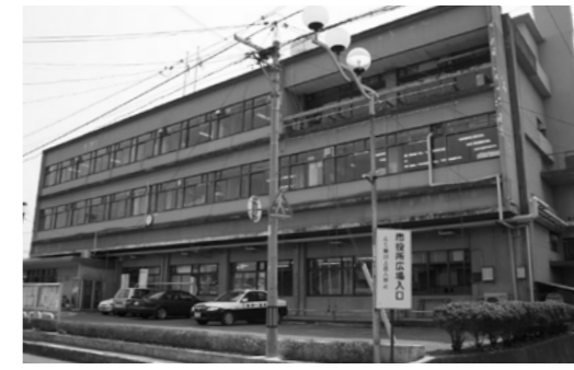
老朽化した本庁舎
