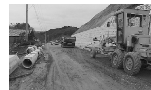
市道紋り中原線改良事業(比和町)
