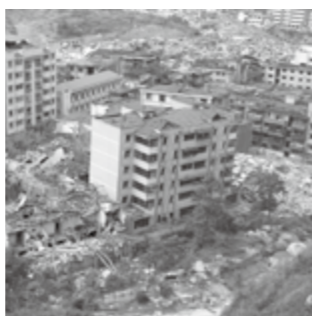
平成20年(2008)四川大地震が発生し、綿陽市に大きな被害を及ぼした
