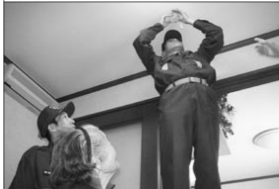
▲設置作業を行なう消防団員
