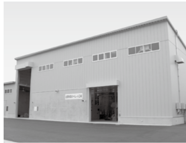
工場の外観(右)と内部の製造設備(中) 屋根に設置された太陽光発電設備(左)
