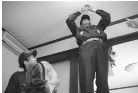
▲設置作業を行なう消防団員
