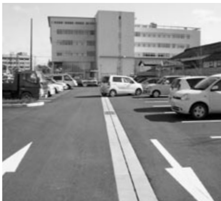
利用が始まった駐車場
