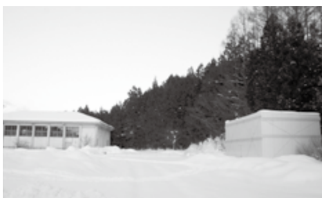
たて約6m×よこ約11m×高さ約5mの雪室(右)
