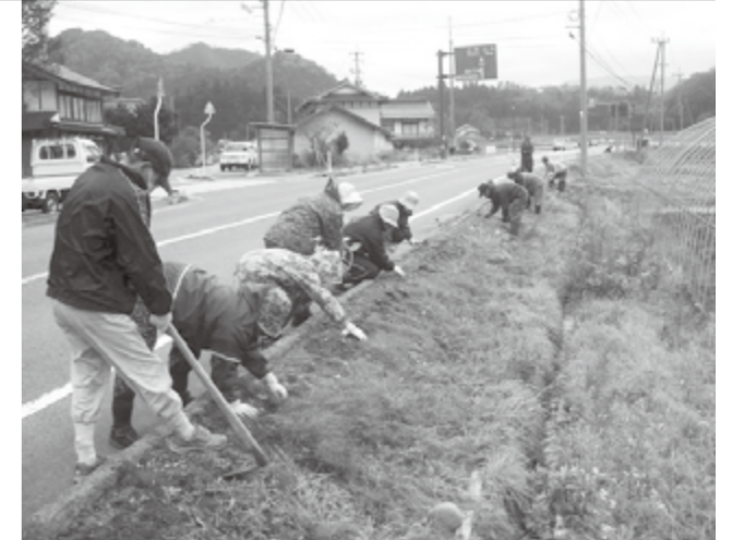
▲王居峠トンネル付近の直線に植栽
