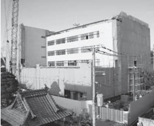
完成間近の新庁舎
