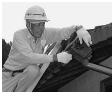
雨どいを修繕する口和町の職人
