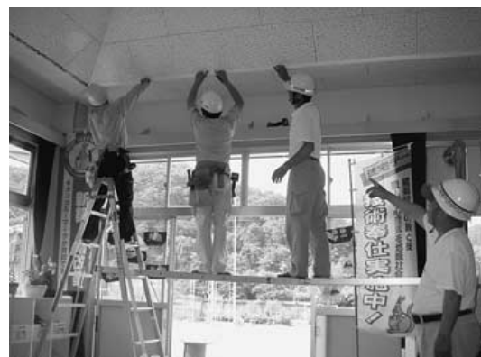
峰田保育所の天井を修繕
