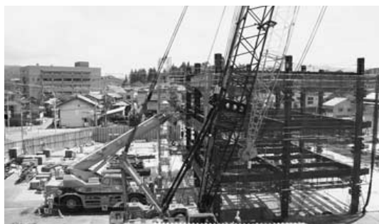
工事が進む新庁舎
