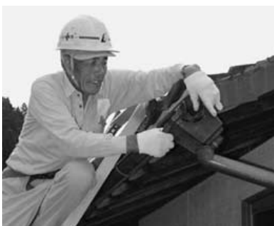
雨どいを修繕する口和町の職人
