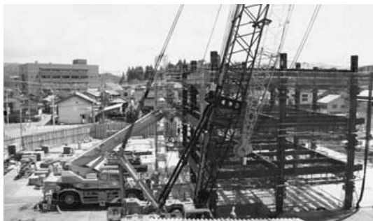
工事が進む新庁舎
