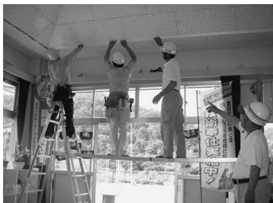
峰田保育所の天井を修繕
