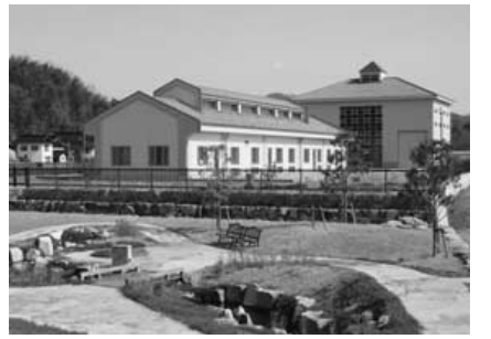
国内最大級の農業集落排水施設
