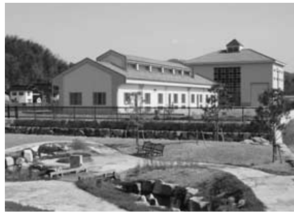
国内最大級の農業集落排水施設
