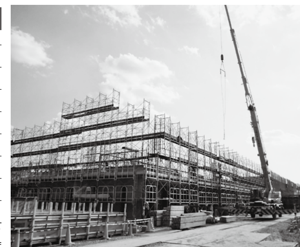
工事が進む庄原中学校
