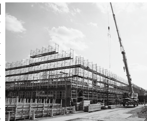
工事が進む庄原中学校
