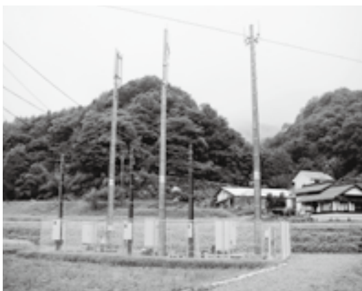
完成した西城福山局
