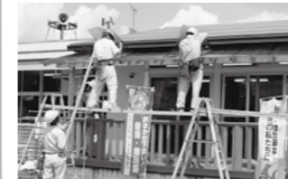
▲テラス屋根を新設(三田市保育所)
