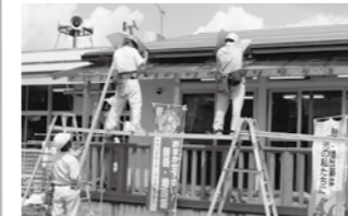
▲テラス屋根を新設(三田市保育所)
