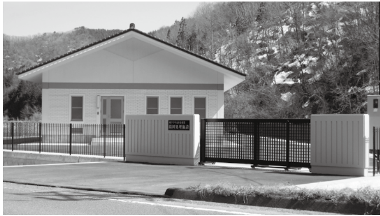
完成した湯川処理場
