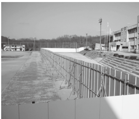
グラウンドに設置された進入防止用の壁
