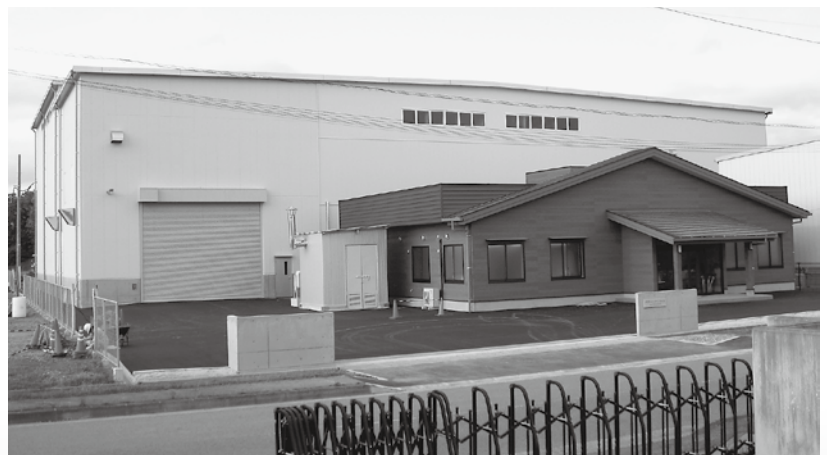
庄原工業団地に整備された木質バイオマス利活用プラント
