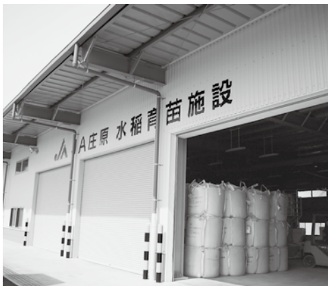
完成した水稻育苗施設
