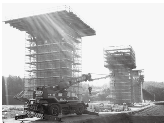
工事が進む中国横断自動車道尾道松江線
