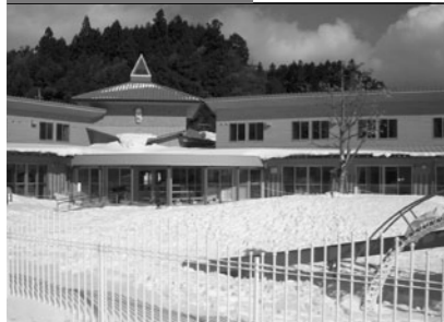
▲完成した木造の新園舎
