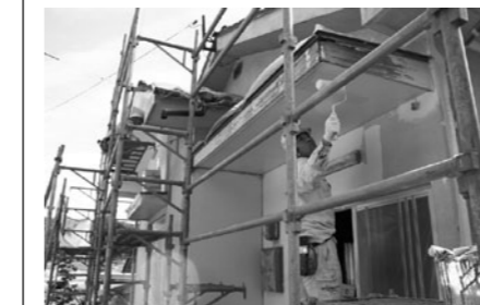
▲明るいクリーム色に塗装された外壁
